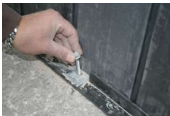
Se till att hålet är rent från betongmjöl, för att kunna dra ner skruven ordentligt.
