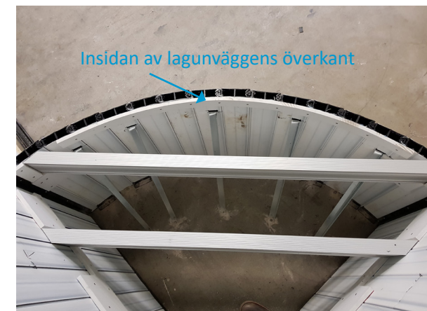
1. Montera en forexlist 60x18x2000 (A) 160mm under lagunväggens överkant (se punkt 1). Använd träskruv 5x60 C4. Skruva fast listen i lederna mellan aqvissponton mot ytterväggen.
