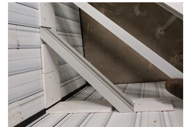
1. Montera en forexlist 60x18x2000 (A) 160mm under lagunväggens överkant (se punkt 1). Använd träskruv 5x60 C4. Skruva fast listen i lederna mellan aqvissponton mot ytterväggen.
