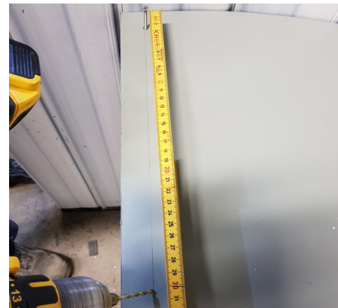
7. Mät in 30 mm från lagunkanten för att fästa skruven i alu-listen som ligger under lagunskivan, avstånd mellan skruvarna cc 300 mm. Använd skruv 4,0x32 längs med kanterna, cc 150 i forexplattan (C).
